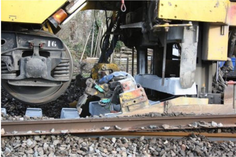
La machine pose automatiquement les nouvelles traverses derrière elle
